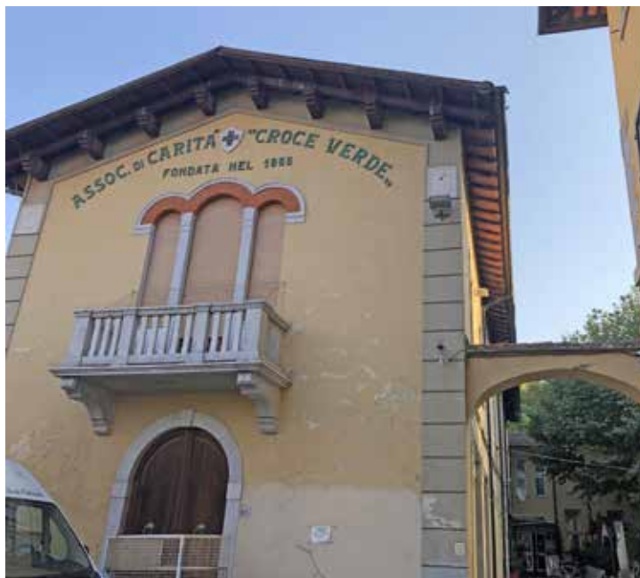
La sede sociale della Croce Verde, in particolare l'“Ex Stallone”, dove è ospitata la Sala Tosi, che sarà interessata dal progetto di ristrutturazione finanziato con risorse proprie dell'associazione
